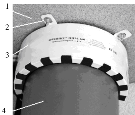
1 – перекрытие; 2 – крепление; 3 – муфта; 4 – труба
